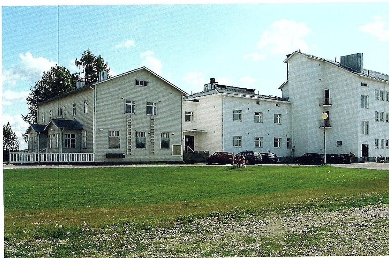
Kolmessa vaiheessa rakennettu vanhainkodin päärakennus. Alun perin taitekattoinen vuonna 1922 hirsistä rakennettu ns. väentupa korotettiin vuosina 1948–50 suoritetuissa rakennustöissä kaksikerroksiseksi, ja sen yhteyteen rakennettiin kaksikerroksinen sairaosasto. Kolmikerroksinen kivirakennus valmistui vuoden 1954 lopulla.
